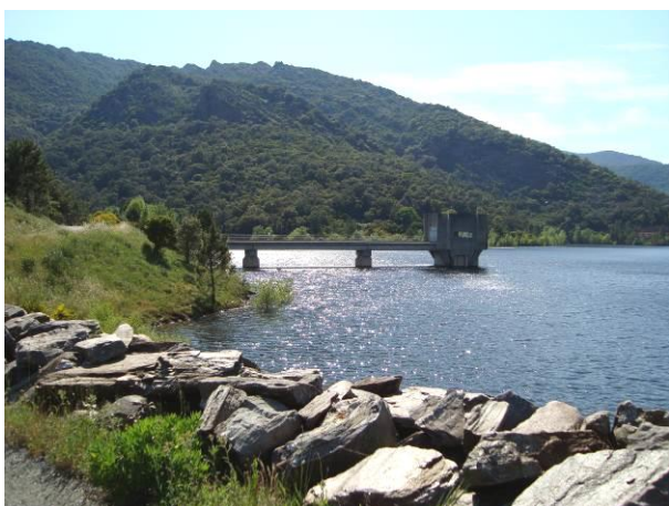
Figure 15 : Photographie de la tour de prise du barrage de la Verne
